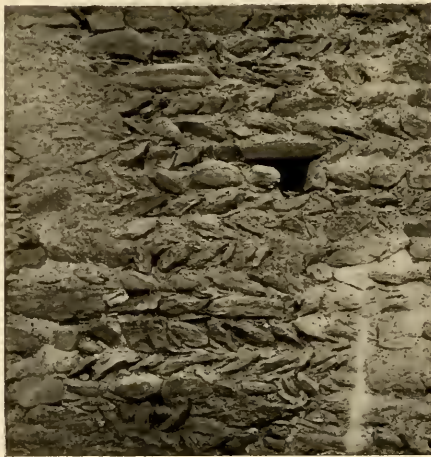
Fig. 343 — Particolare costruttivo dei muri di Susa (secoli dal IV al VI)
